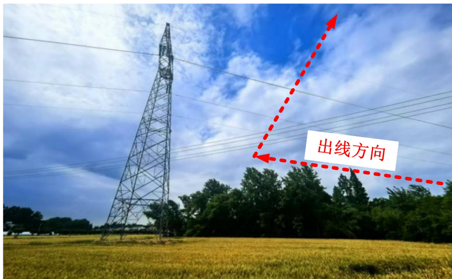
图 2-10 钻越处现场照片
