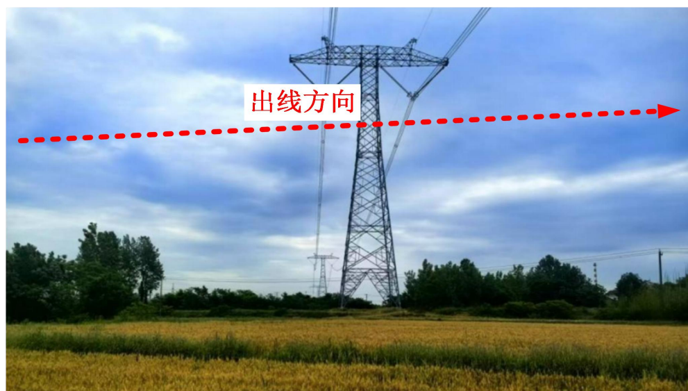
图 2-8 钻越处现场照片
