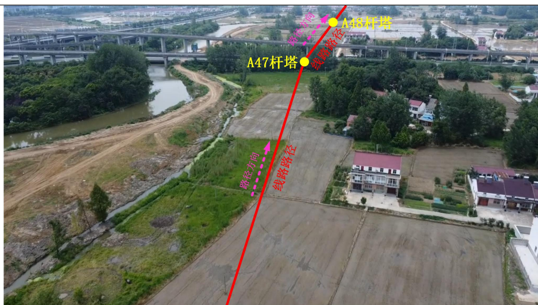
线路沿线土地现状（A47杆塔~A48杆塔）
