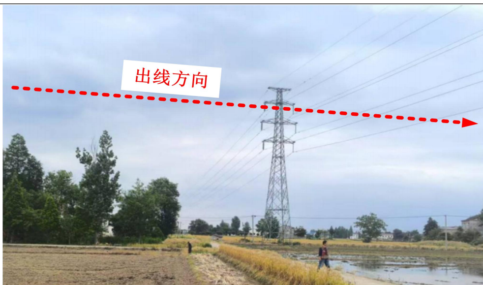
图 2-11 跨越处现场照片
