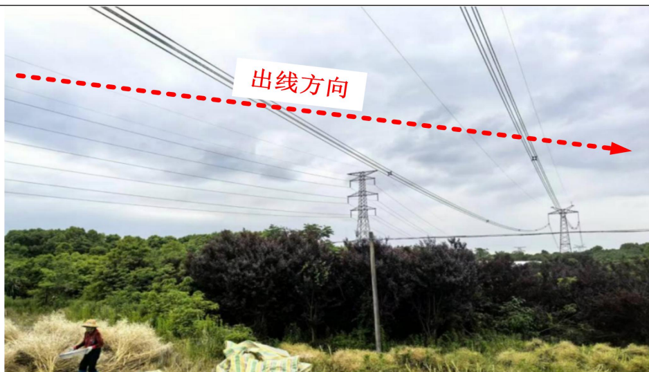
图 2-9 钻越处现场照片
