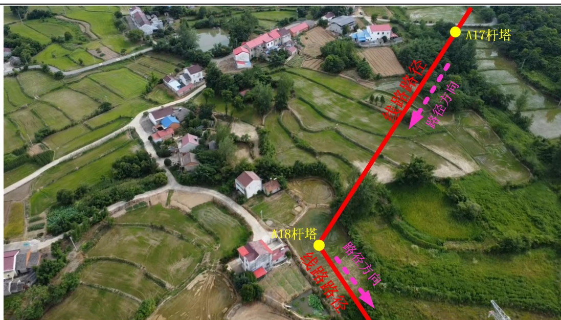
线路沿线土地现状（A17杆塔~A18杆塔）
