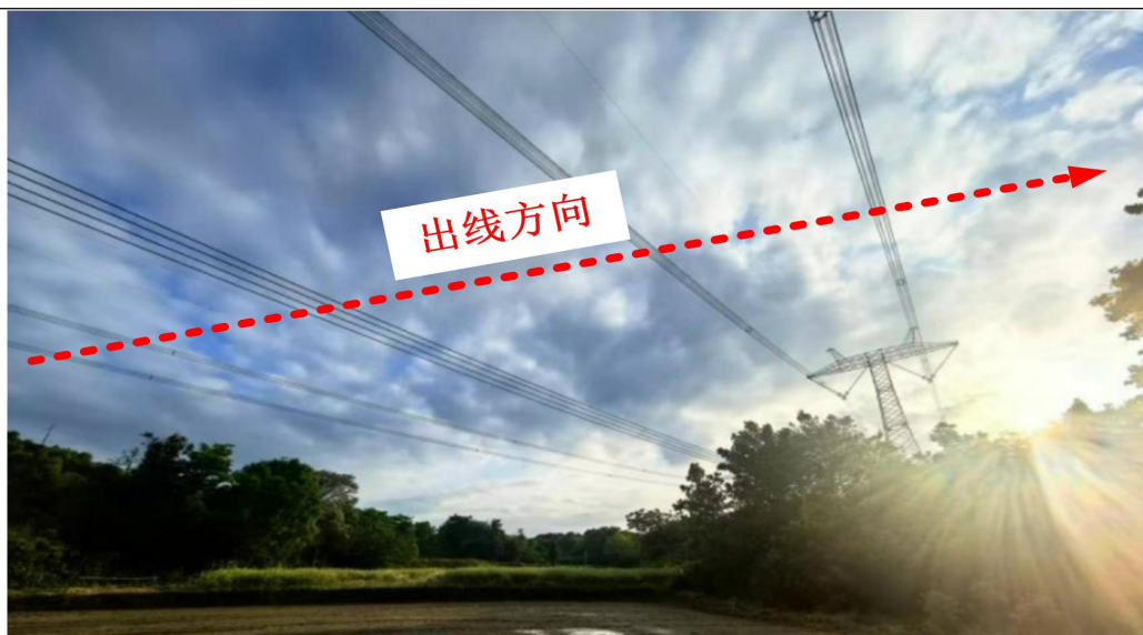
图 2-7 钻越处现场照片
