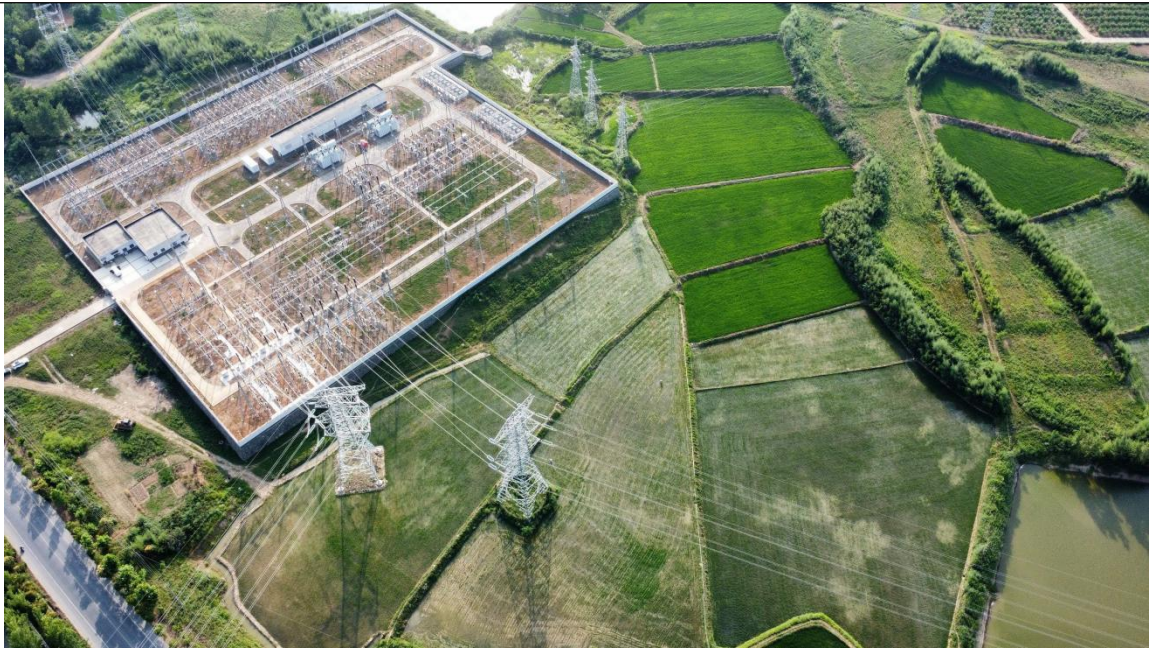
图 2-6 220kV 叶桥变现状
