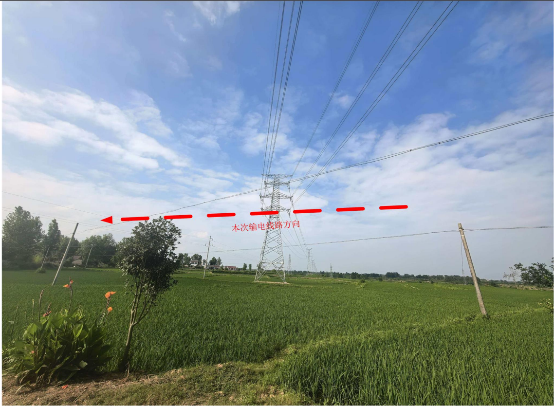
图 2-9 钻越处现场照片
