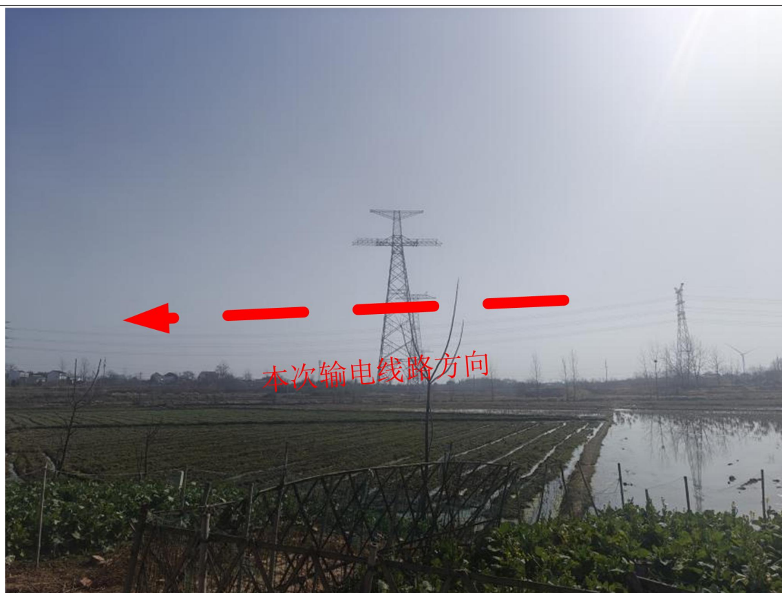
图 2-12 钻越处现场照片
