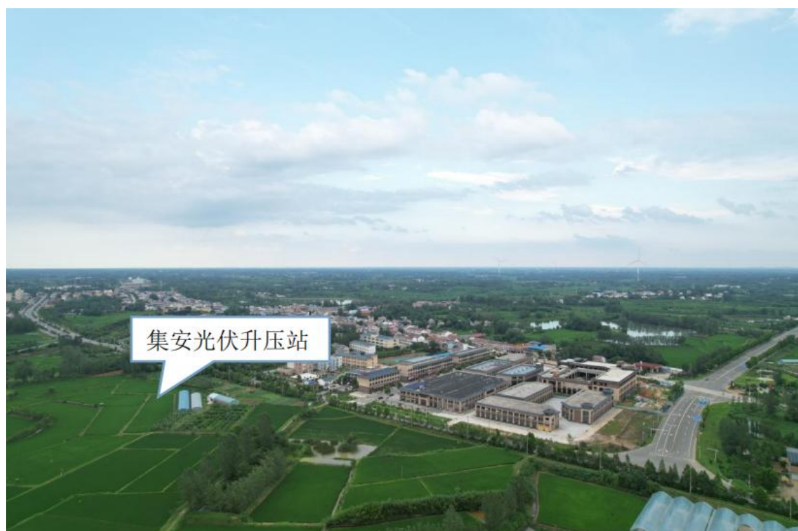
图 2-3 集安光伏升压站站址现状
