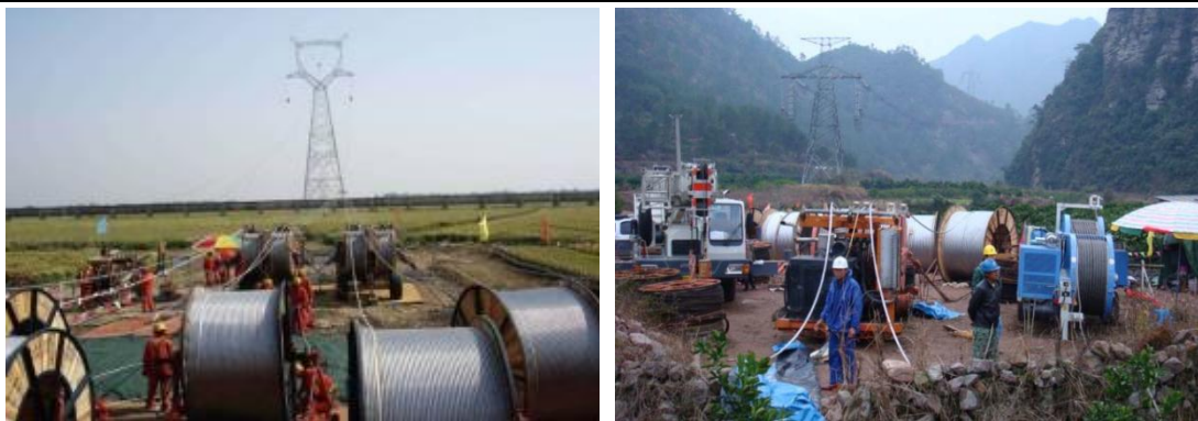
图 2.4-1 牵张场布置形式示意图
