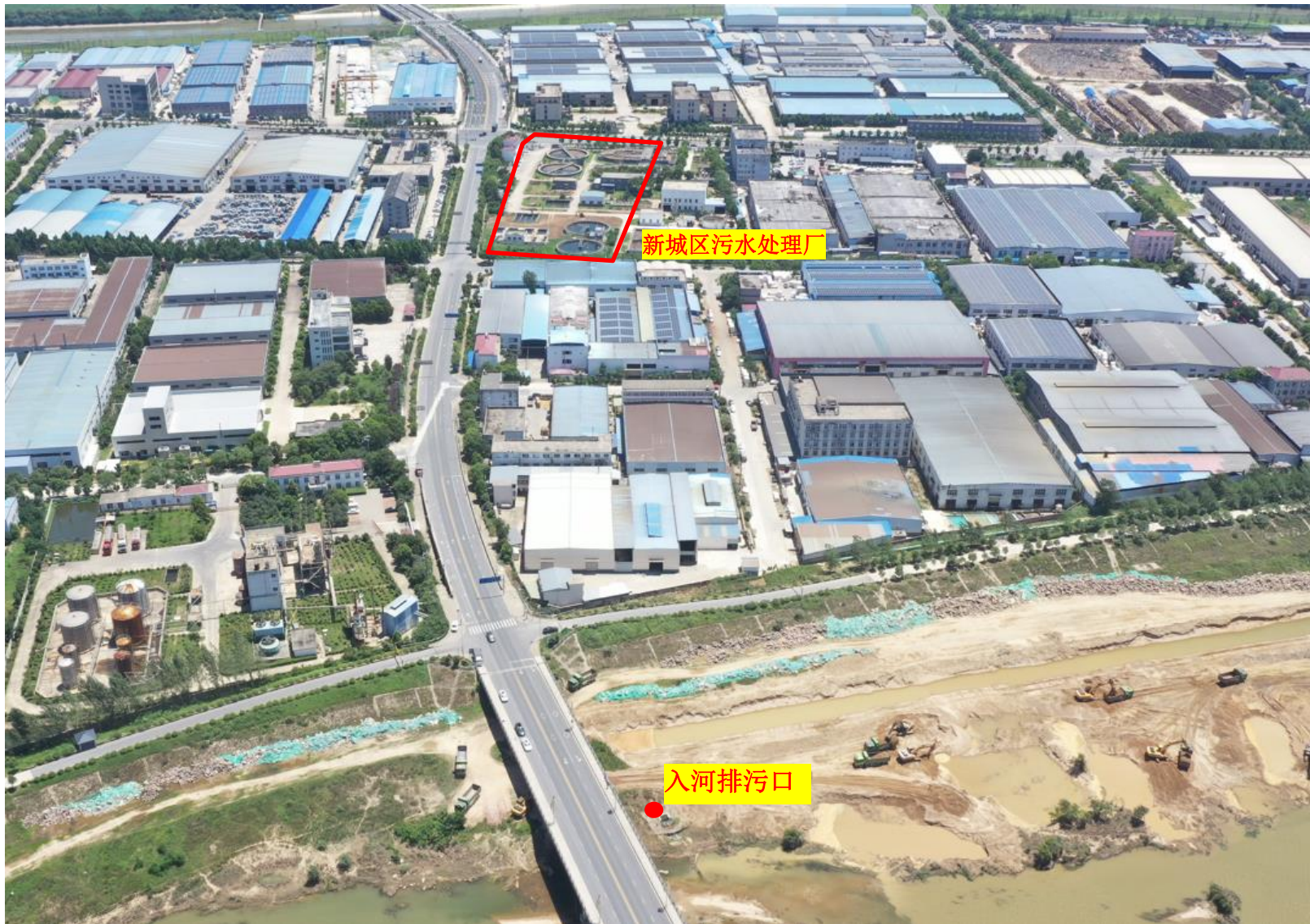
图 5.1-2 污水处理厂及排污口航拍图
