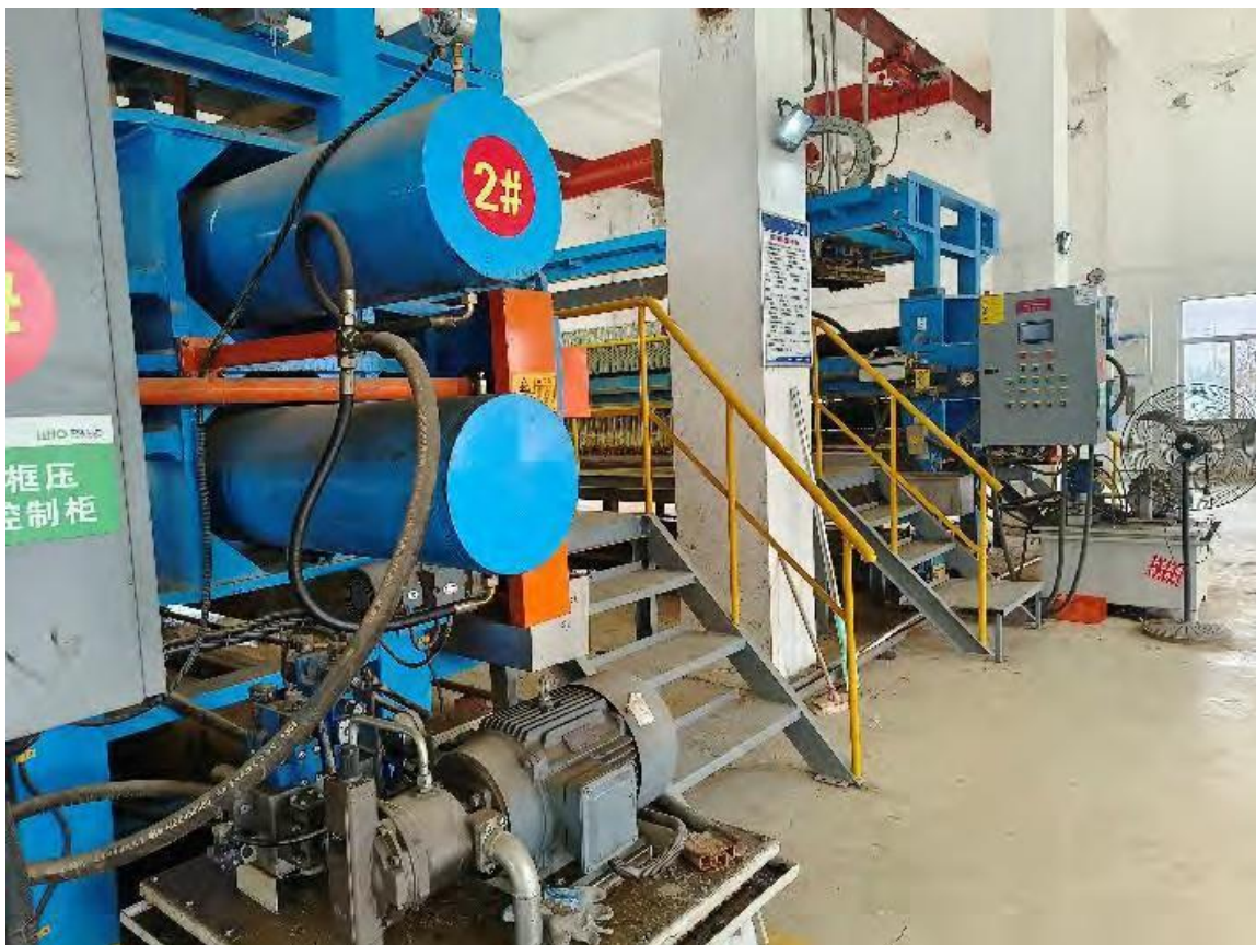
图 3.3-11 污水厂脱水机房现状
