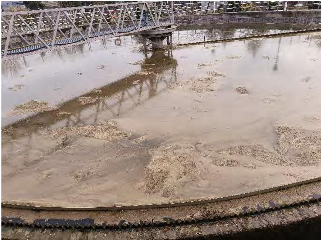
图 3.3-9 污水厂二期二沉池现状
