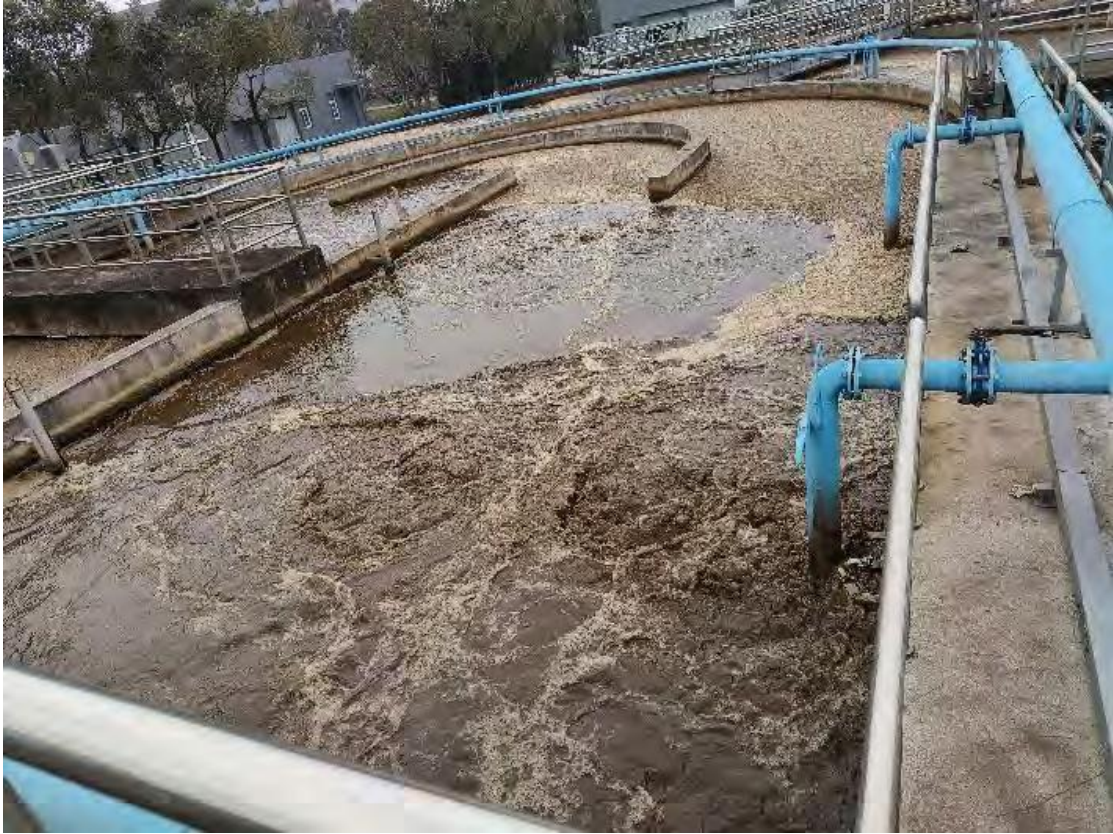
图 3.3-6 污水厂一期氧化沟现状
