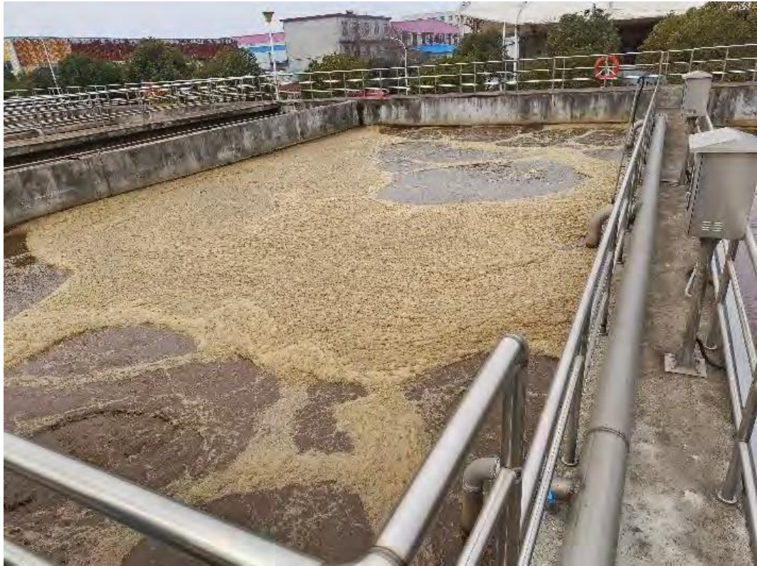
图 3.3-8 污水厂二期生化池现状
