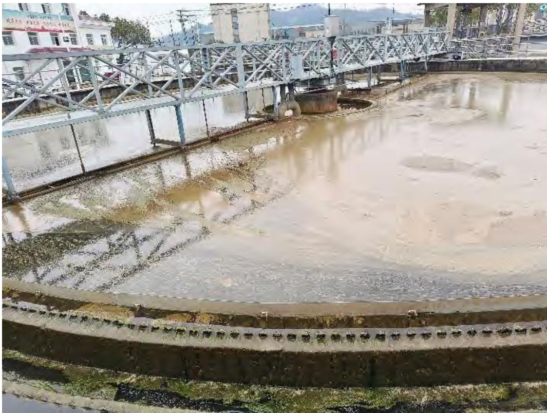
图 3.3-7 污水厂一期二沉池现状
