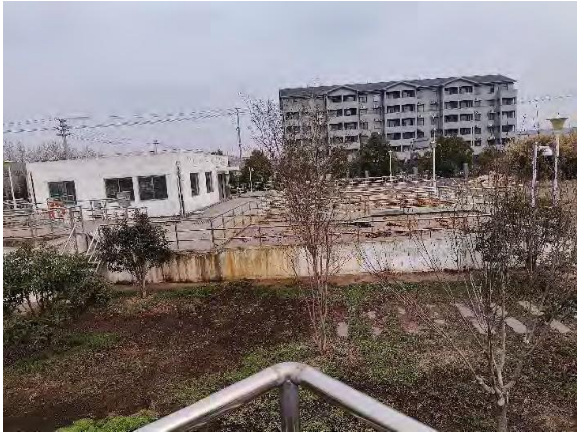
图 3.3-10 污水厂高效沉淀现状
