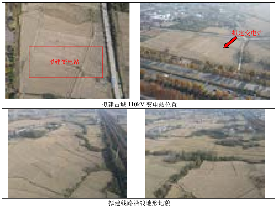
图3-2 变电站及线路沿线地形地貌
