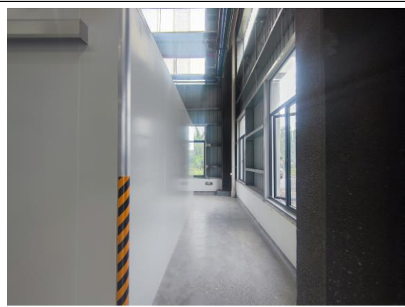
X 射线检测室北侧（走道）
