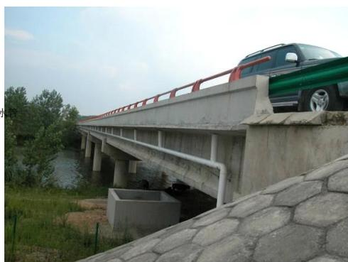
图 5.1-1 封闭式纵向排水系统示意图
