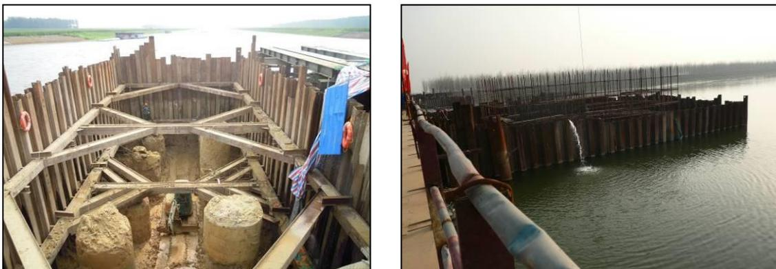
图 5.3-1 安徽怀洪新河桥梁桩基施工设置钢围堰周围保持水体清澈
