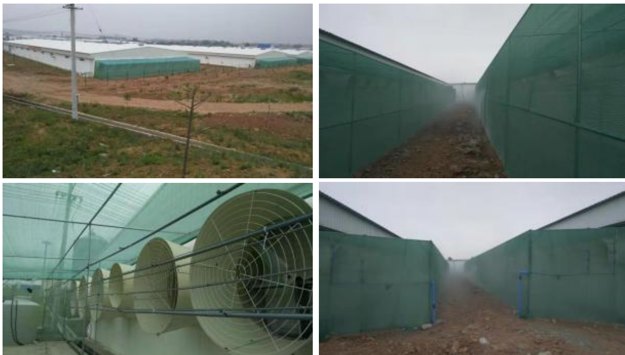
图 6.2-1 猪舍拟采取的除臭装置图
