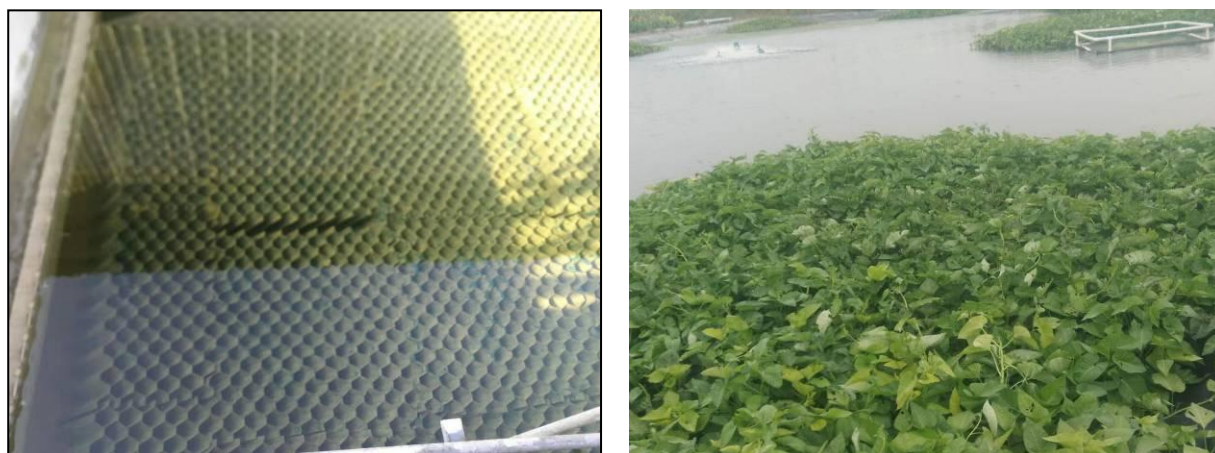
图 6.2-9 场内氧化塘铺防渗膜、种植水生植物
