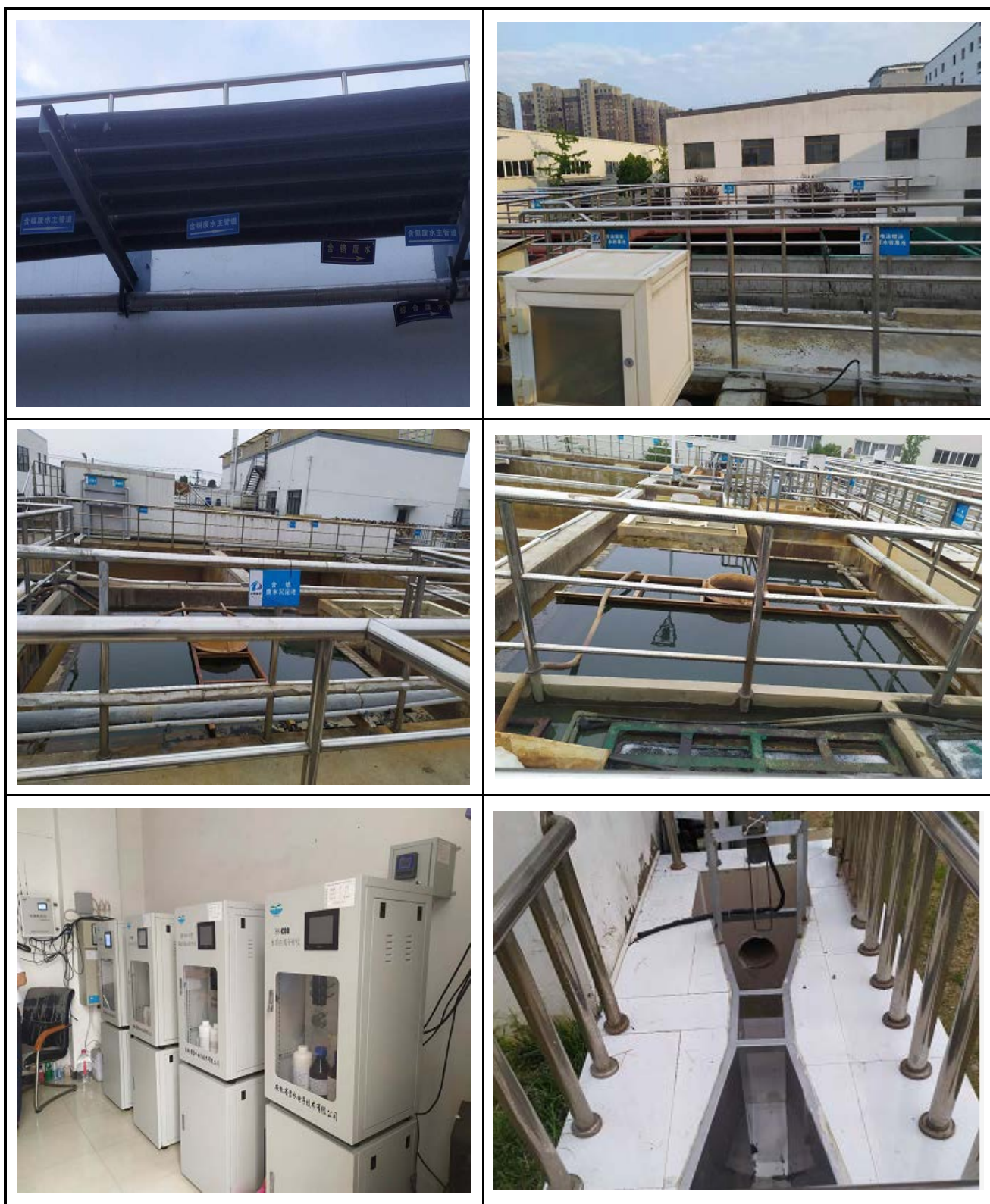
图 3.5.1-5 废水处理工程实景图
