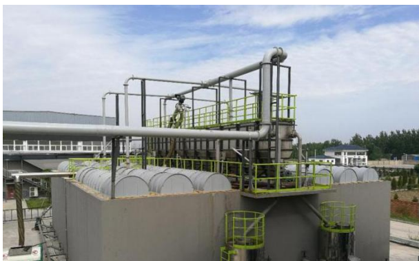
水解酸化池及除砂器参考图
