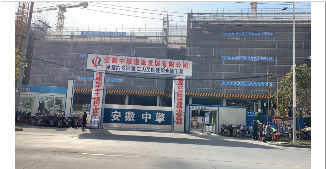
门诊内科综合大楼在建工地
