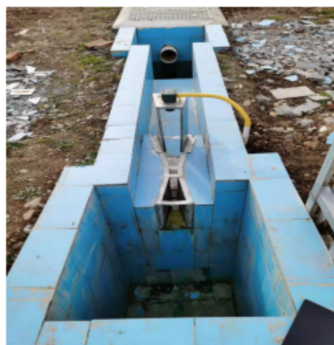
图2 新建污水处理站排污口
