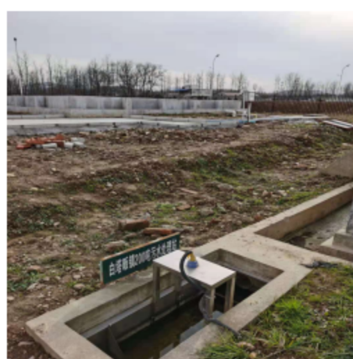
图6 已建污水处理站（老站）设施及排污口
