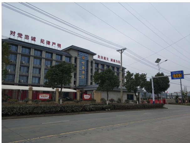
1#土壤（叶集区消防大队）
