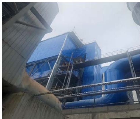
冠盛蓝玻璃除尘、脱硫、脱硝装置
