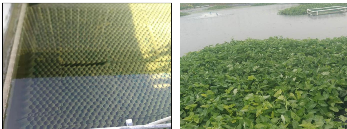
图 6.2-9 场内氧化塘铺防渗膜、种植水生植物
